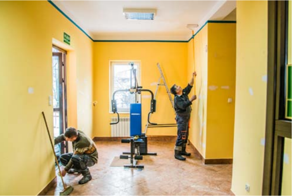
Remont świetlicy w Bukowcu.
