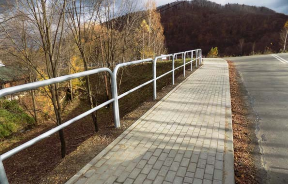
Chodnik przy drodze gminnej w Bukowcu.
