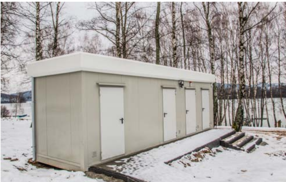
Budynek sanitarny wykonany został w technologii kontenerowej.
