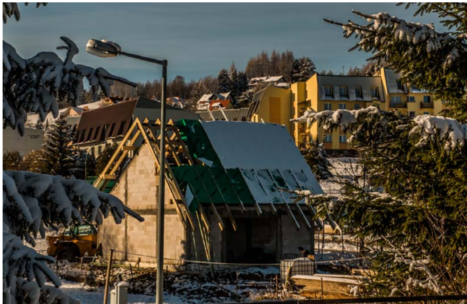
Budowa Centrum Informacji Uzdrawiskowo-Turystycznej w Polańczyku.
