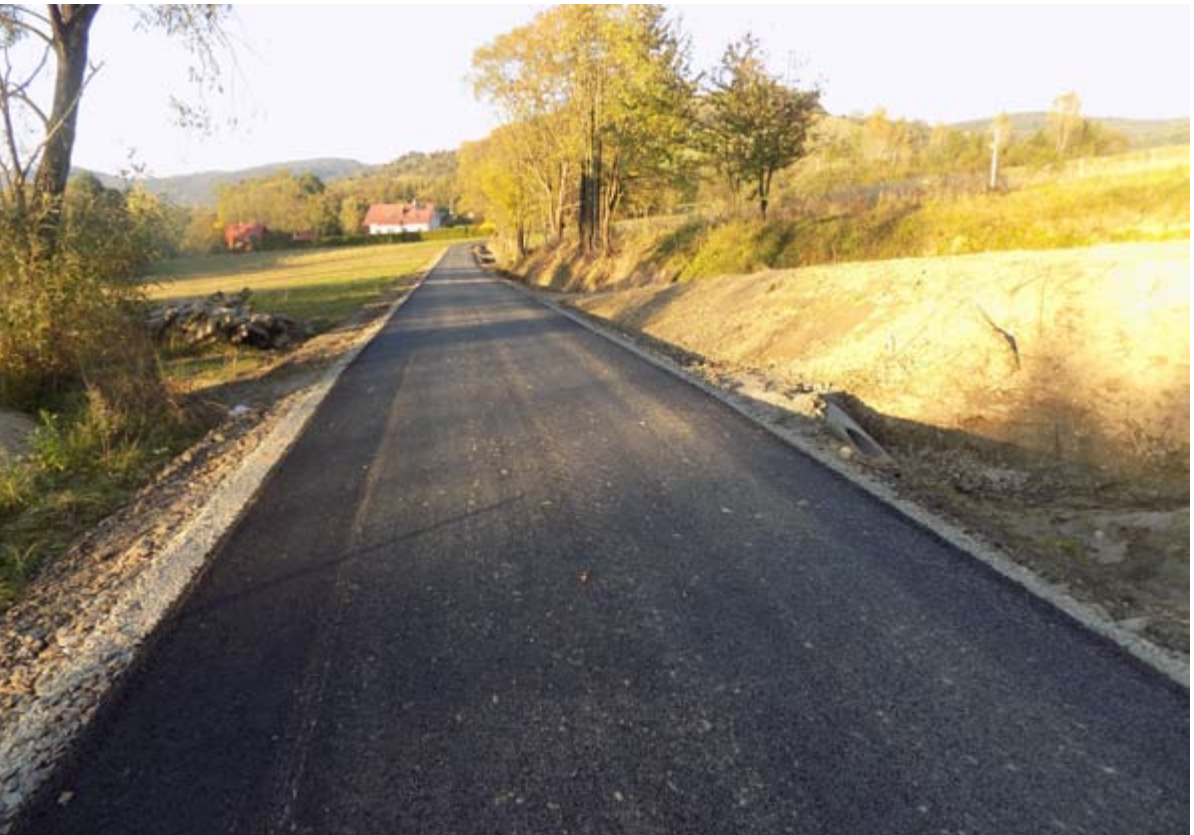
Droga Terka – Polanki.
