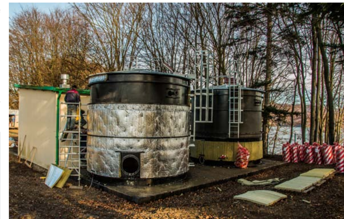
Remont stacji uzdatniania wody w Polańczyku.
