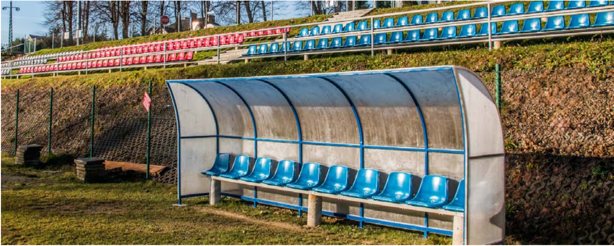
Nowe boksy i siedziska zainstalowane na stadionie w Polańczyku.
