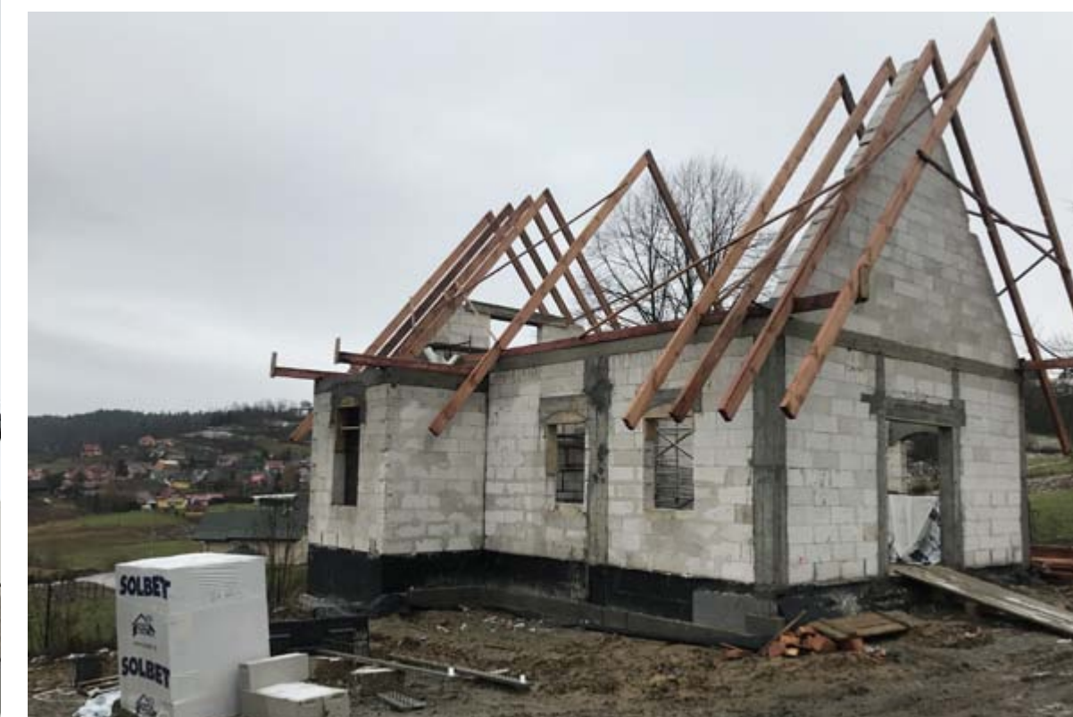
Budowa kaplicy cmentarnej w miejscowości Zawóz.
