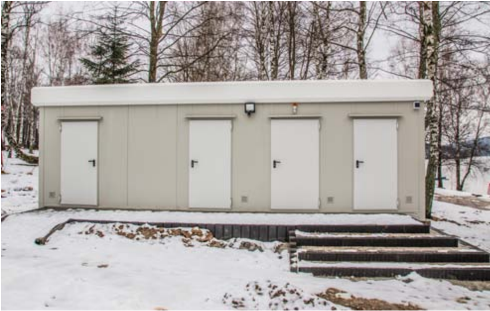
Zaplecze sanitarne uwzględnia także potrzeby osób niepełnosprawnych.
