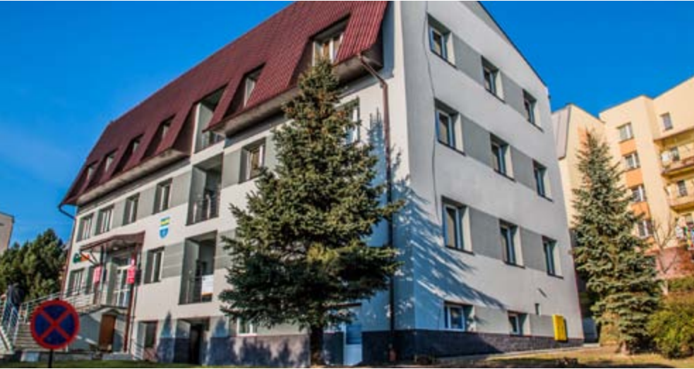
Budynek Urzędu Gminy.
