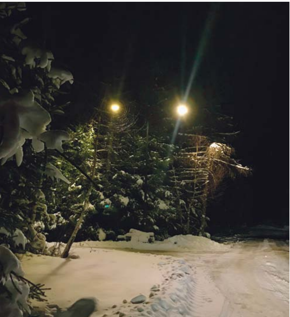
Oświetlenie uliczne w miejscowości Terka.
