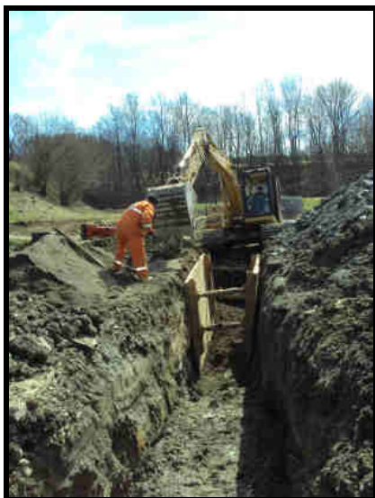
Budowa kanalizacji w Myczkowie
