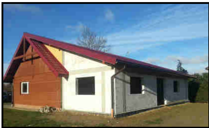
Rozbudowa świetlicy w m-ci Werlas (koszt: 58 904,45 zł)
