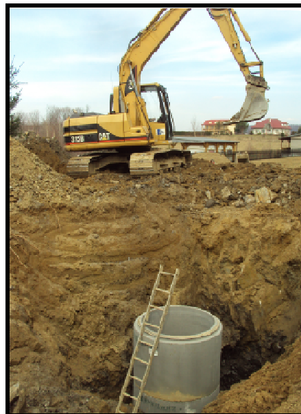
Budowa kanalizacji w Myczkowie
