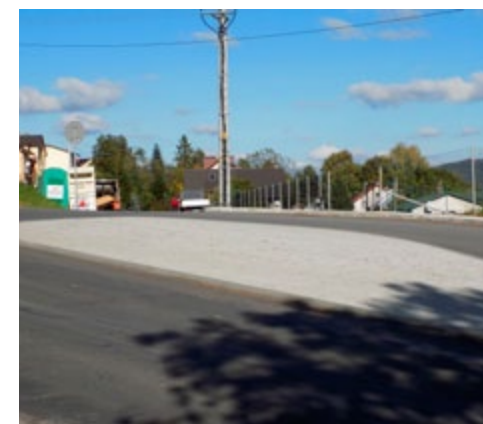
Wyremontowana ulica Bieszczadzka i zorganizowany wjazd na ulicę Równą oraz Dworską w miejscowości Polańczyk. Fot.: UG Solina
