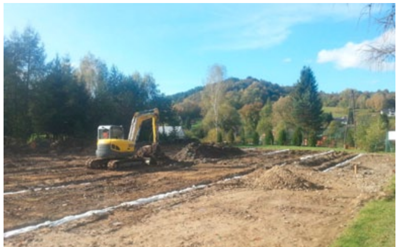
Budowa boiska wielofunkcyjnego w Bóbrce. Fot.: Z. Domański
