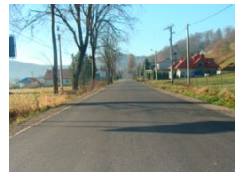
Droga w miejscowości Myczkowce prowadząca do Zwierzynia. Fot.: UG Solina
