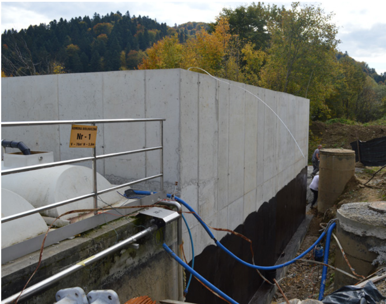
Rozbudowa oczyszczalni ścieków w miejscowości Wołkowyja.
