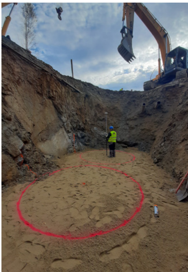
Budowa sieci tłocznej Polańczyk–Berezka.
